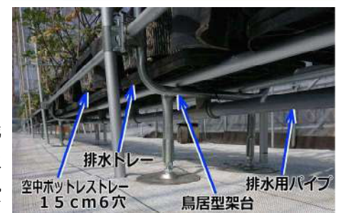
鳥居型架台での排水トレーの設置例
