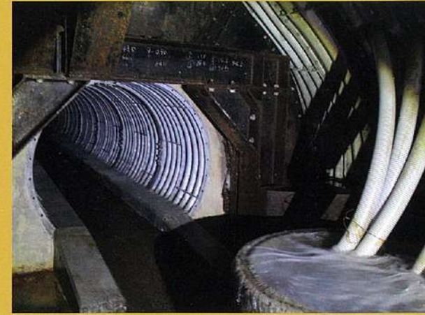
排水トンネル状況
