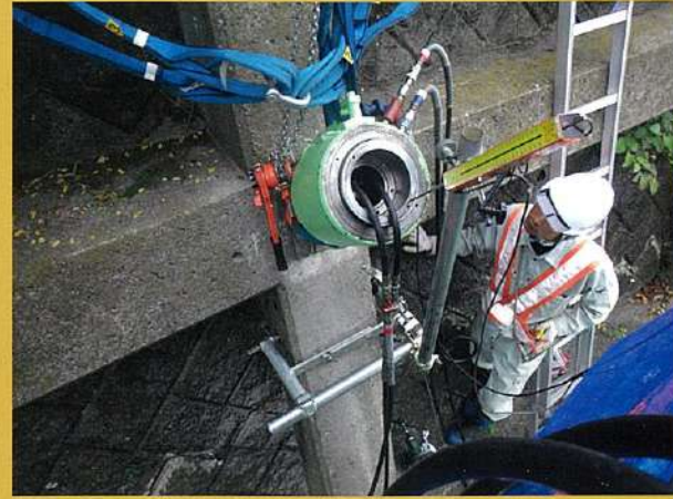
アンカー工 リフトオフ試験
