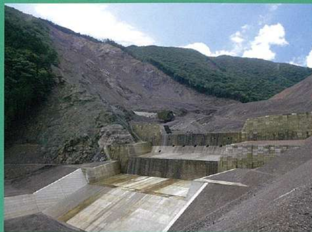
赤谷地区復旧状況
