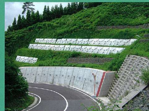
林道災害復旧
