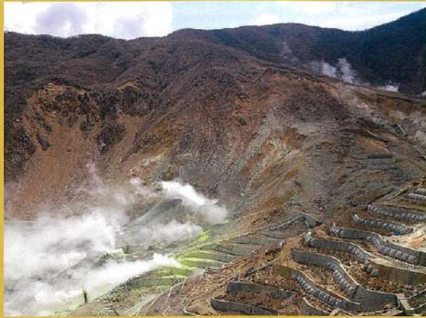
温泉地すべり地区のアンカー工施工状況
