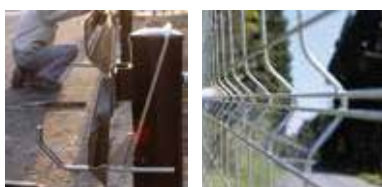
▼ガードレールのビームとB L加工
