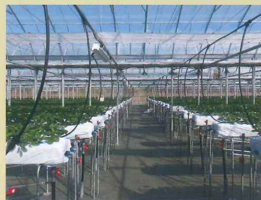
施用配管の様子
